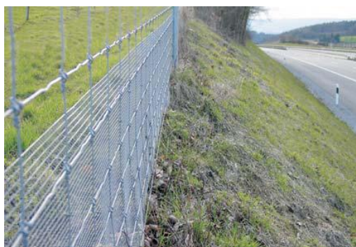
Figura 5.1 – Vedação com malha de densidade menor para evitar o atravessamento de espécies de fauna de pequenas dimensões (Fonte: Ministerio de Medio Ambiente. 2006)
