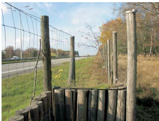
Figura 5.3 – Rampa de escapatória (Fonte: Ministerio de Medio Ambiente. 2006)
